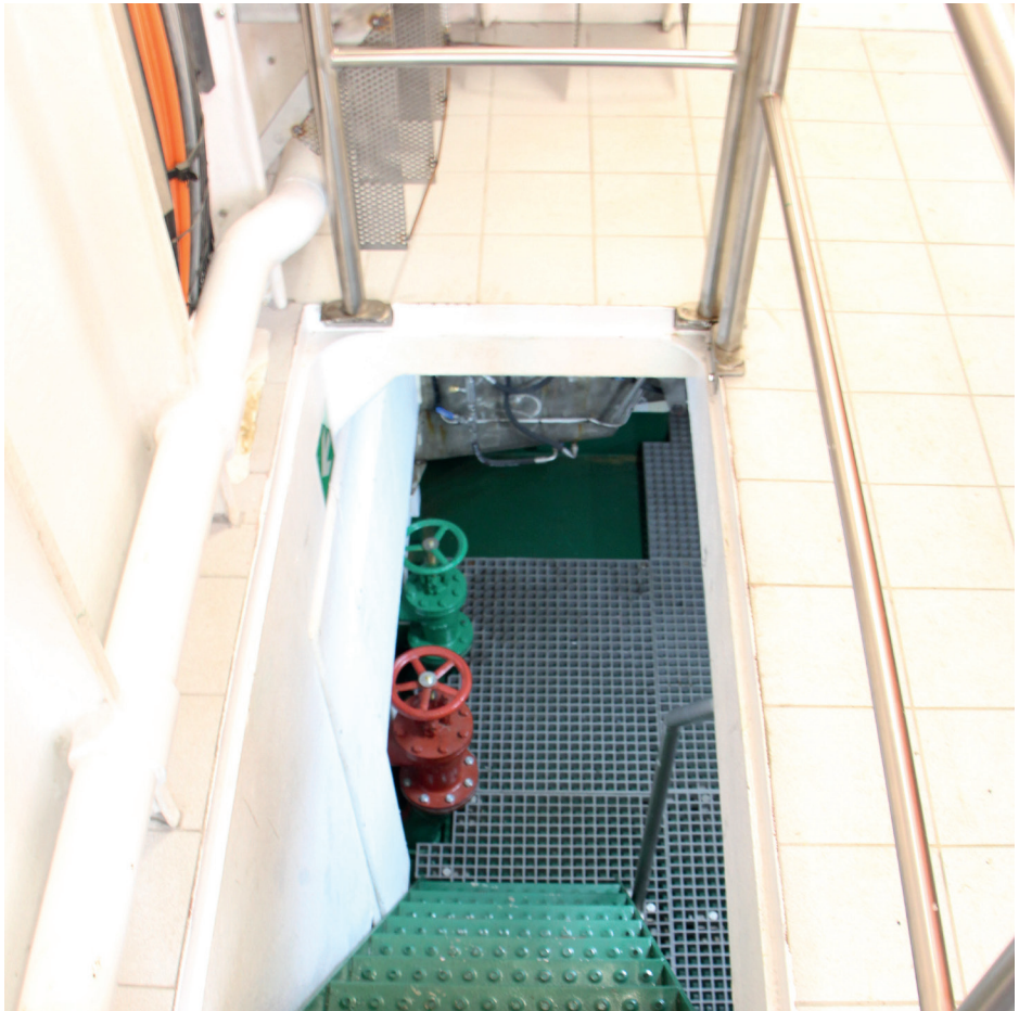
Escalera con barandilla
