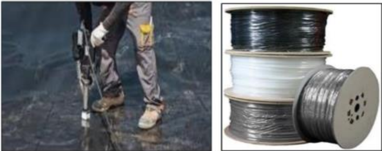
Figura 20: soldadura por extrusión (izq) - rollo de material de aporte (der).
