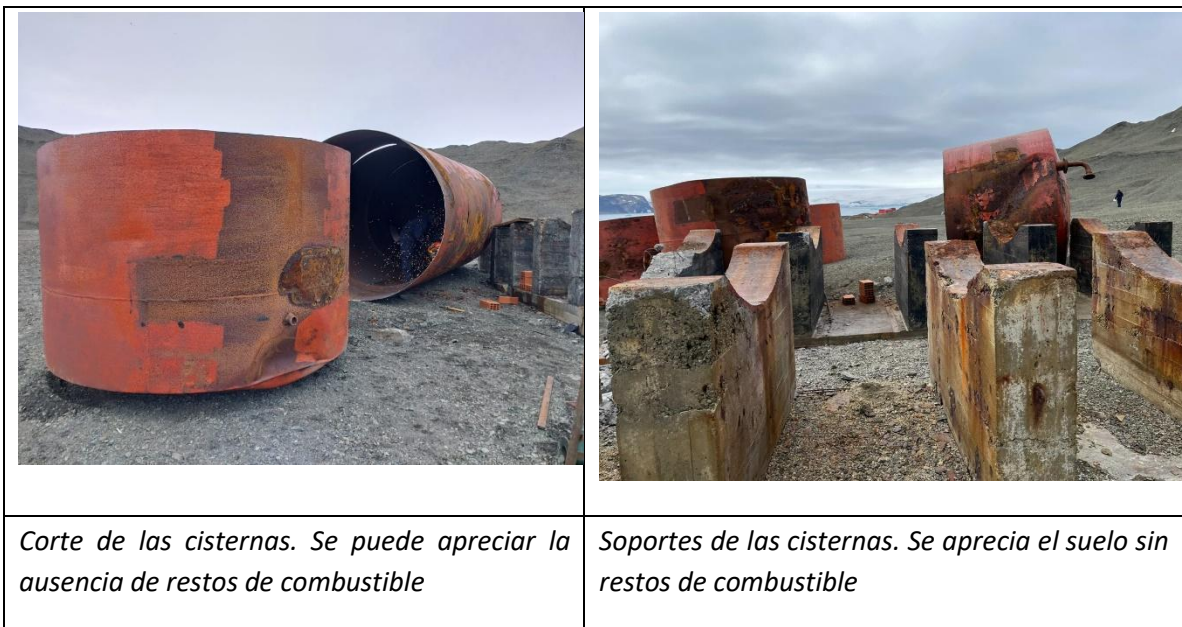
Figura 16: Inspección ocular, evaluación de ausencia de restos de combustibles.
