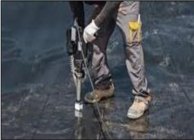
Figura 8: soldadura por extrusión
