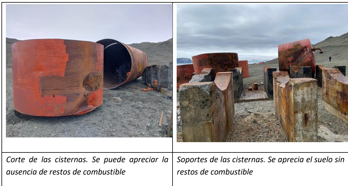
Figura 1: inspección ocular, evaluación de ausencia de restos de combustibles.
